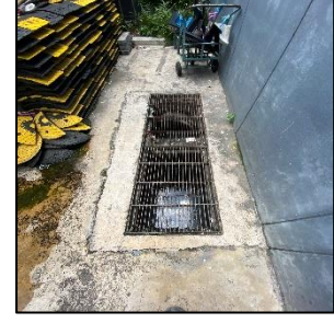
ภาพที่ 2.1-14 บ่อพักน้ำสุดท้ายด้านถนนสายเก่า
