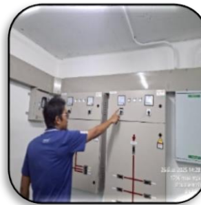
ภาพที่ 2.1-7 ระบบจ่ายไฟฟ้า และไฟฟ้าสำรอง พร้อมการตรวจสอบบำรุงรักษา
