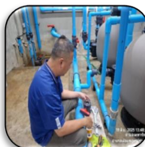
ภาพที่ 2.1-9 ระบบกรองน้ำสระว่ายน้ำ
